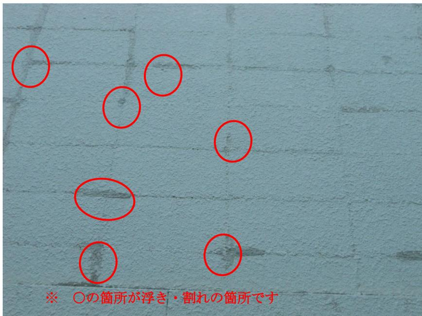
外壁面における浮き・割れの箇所状況
