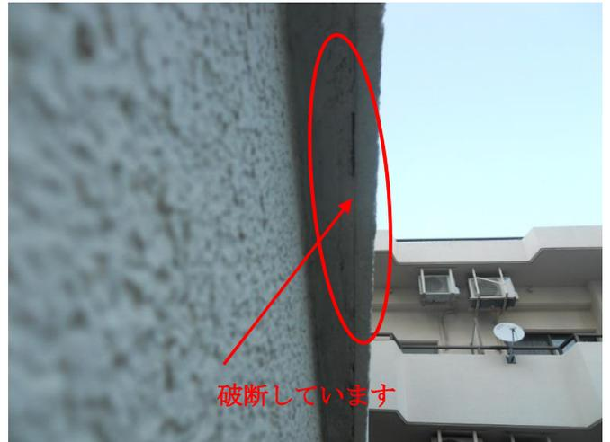
鉄骨梁周辺シーリング材の破断箇所②(拡大)
